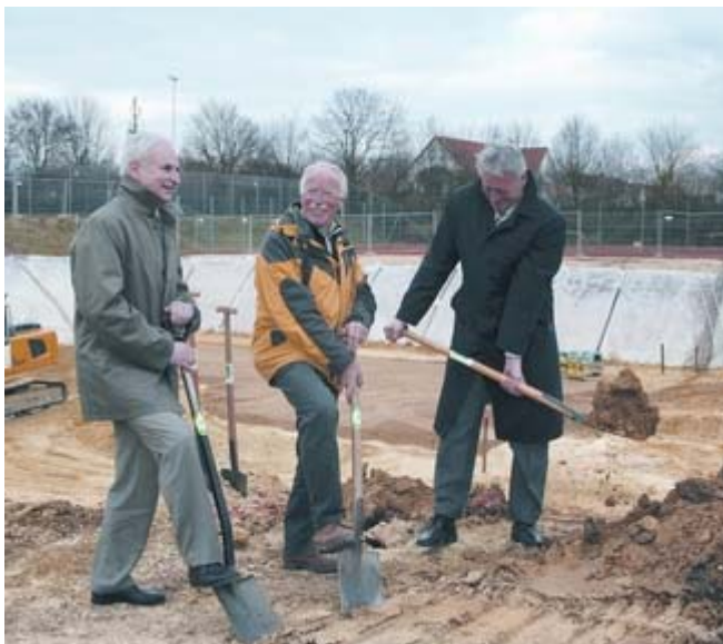
Landrat Herbert Mirbeth, Sektionsvorsitzender Toni Putz und Lappersdorfs Bürgermeister Erich Dollinger (von links) beim Spatenstich Foto: Gruber
